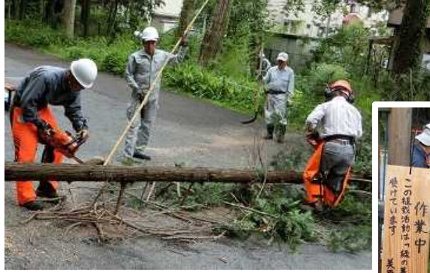
支障木の伐採処理
